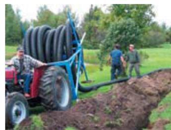
*Поставка на место выполнения работ в соответствии с заказом; монтаж непосредственно из бухты*
