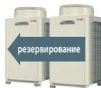
При частичной загрузке системы предусмотрена автоматическая ротация основного и резервного модулей, составляющих наружные агрегаты City Multi Y ZUBADAN PУHY-HP400/500YSHM-A, для выравнивания рабочего ресурса обоих компонентов.
