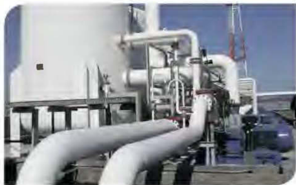
Трубопроводная система «Восточная Сибирь-Тихий океан», г. Белогорск.
