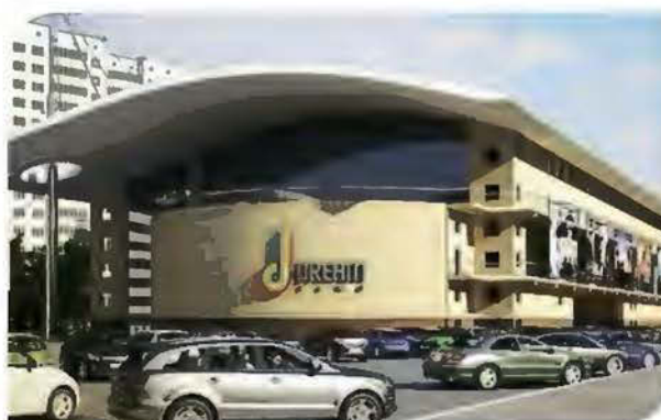
Торгово-развлекательный центр «ДримТаун», г. Киев
