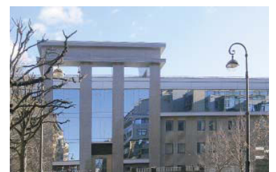
Административное здание, ул. Чапыгина, г. Санкт-Петербург
